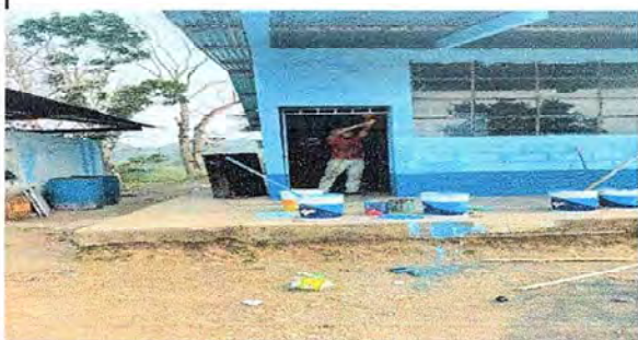
Remosamiento de puertas en el primer modulo se lijo y pinto la puerta
