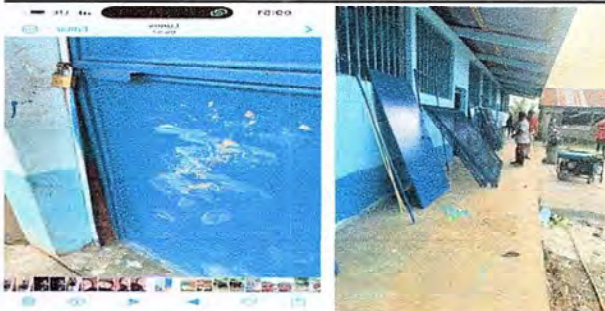
Cambio de puerta y balcones de los modulos
