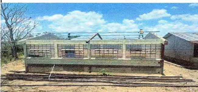
Cambio de techado de una de las aulas del modulo numero 3
