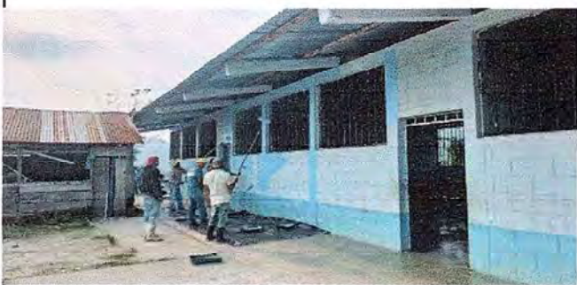
Pintado de interior y exterior de los modulos 1,2 y 3
