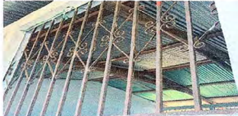
remosamiento de balcones del modulo numero 3
